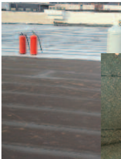
Bitumineuse dakbedekking aan begin van levenscyclus.
